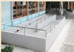
玄関スロープ
