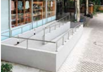
玄関スロープ
